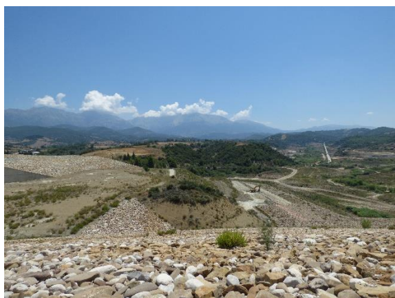
Εικόνα 14. ΒΑ άποψη απ' τη στέψη του φράγματος
