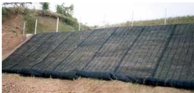
Εικ. 7.8 Διάστρωση τρισδιάστατου γεωπλέγματος
