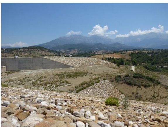
Εικόνα 13. ΒΑ άποψη απ' τη στέψη του φράγματος.
