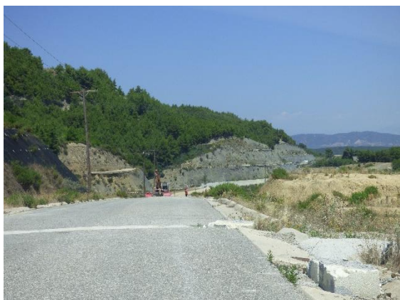
Εικόνα 9. Διαμορφώσεις των πρανών κατά μήκος της οδού Πάτρας-Τρικάλων.
