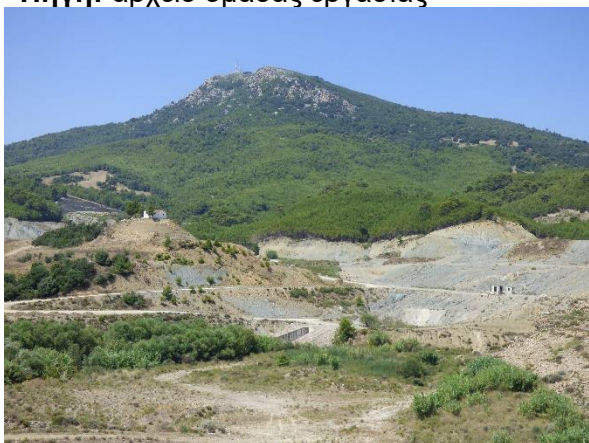
Εικ. 6. Δυτική άποψη του φράγματος προς το Κομποβούνι με εμφανείς τις εργασίες διάνοιξης.
