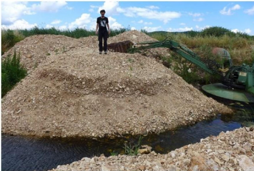
Φωτ 15. 20.06.2014 Τομή στον κάθετο δρόμο, στην επαφή με το παλαιό ανάχωμα Αμφιθέας. Το ύψος των επιχωματώσεων διαπλάτυνσης είναι περί τα 4 μέτρα μέχρι το νερό
