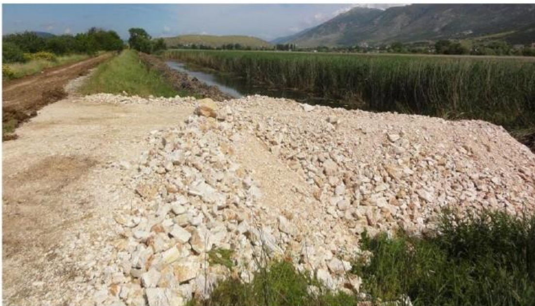
Φωτ 7. 11.05.2013 Ανάχωμα Αμφιθέας, παράνομες επιχωματώσεις αδρανών διαπλάτυνσης. Διακρίνεται το πλάτος στέψης του παλαιού αναχώματος
