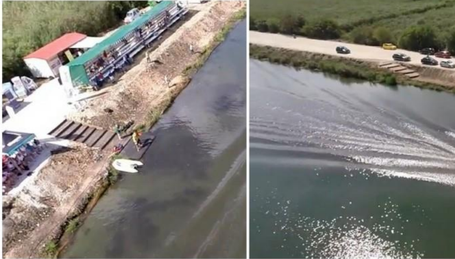
Φωτ 13-14. 4 -7 Σεπτεμβρίου 2014 Ξύλινη κλίμακα, αναβαθμοί κατασκευασμένοι πάνω στις παράνομες επιχωματώσεις διαπλάτυνσης του αναχώματος Αμφιθέας. Φωτογραφίες από https://www.youtube.com/watch?v=XgCHaS90tIE
