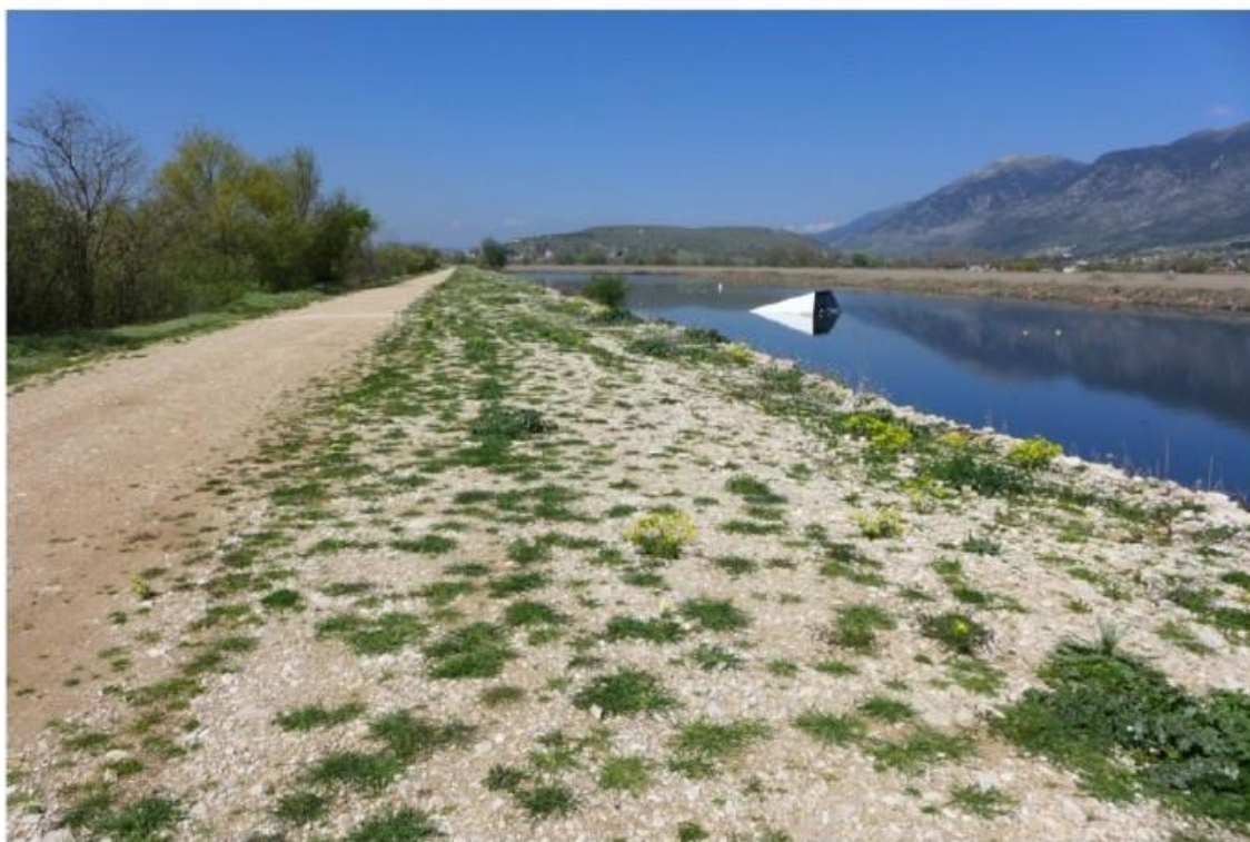
Φωτ 8. 31.03.2014 Το πλάτος στέψης του αναχώματος Αμφιθέας μετά τη διαπλάτυνση έχει σχεδόν υπερδιπλασιαστεί
