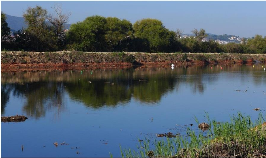
Φωτ 6. 03.10.2013, πλευρική άποψη των επιχωματώσεων διαπλάτυνσης του αναχώματος Αμφιθέας. Διακρίνεται και η επιφανειακή διάστρωσή τους με αδρανή.
