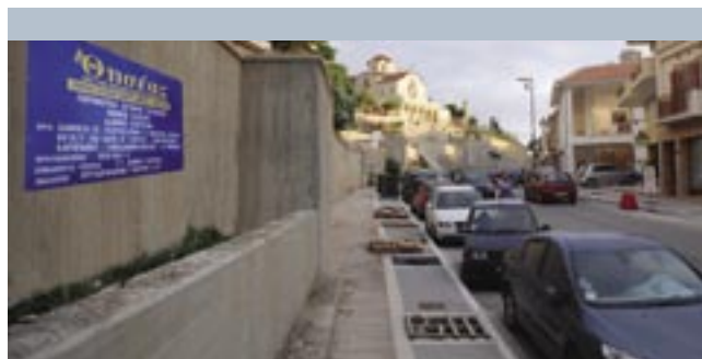
Πάτρα: Διάνοιξη οδού Αγίου Γεωργίου
