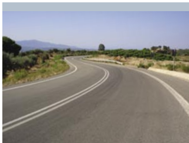
Βελτίωση της Επαρειακής Οδού «Μιράκα-Λάλας-Λαμπεΐα»
